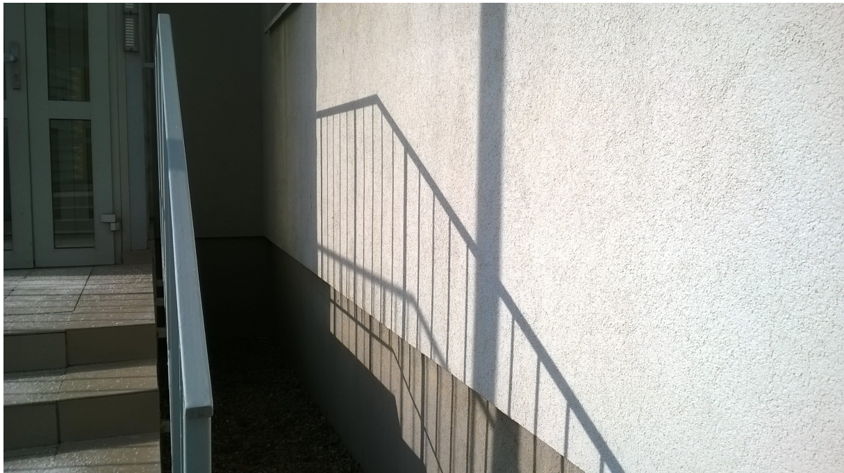
Fot. 12 Cokół między klatką E i F
