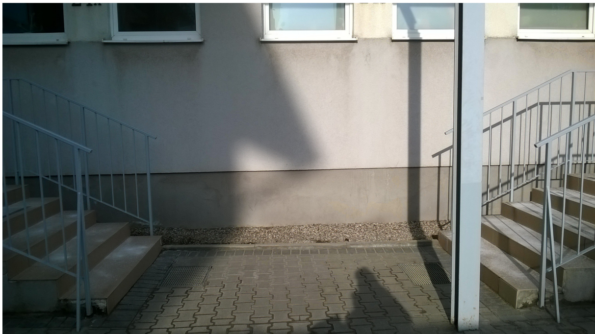
Fot. 10 Cokół między klatką A i B
