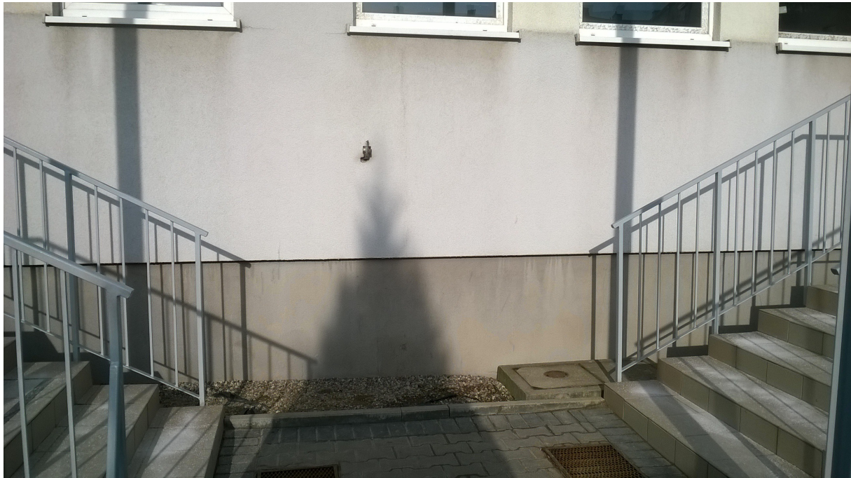
Fot. 11 Cokół między klatką E i F
