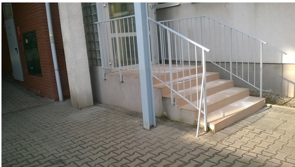
Fot. 8 Bok schodów przy klatce A
