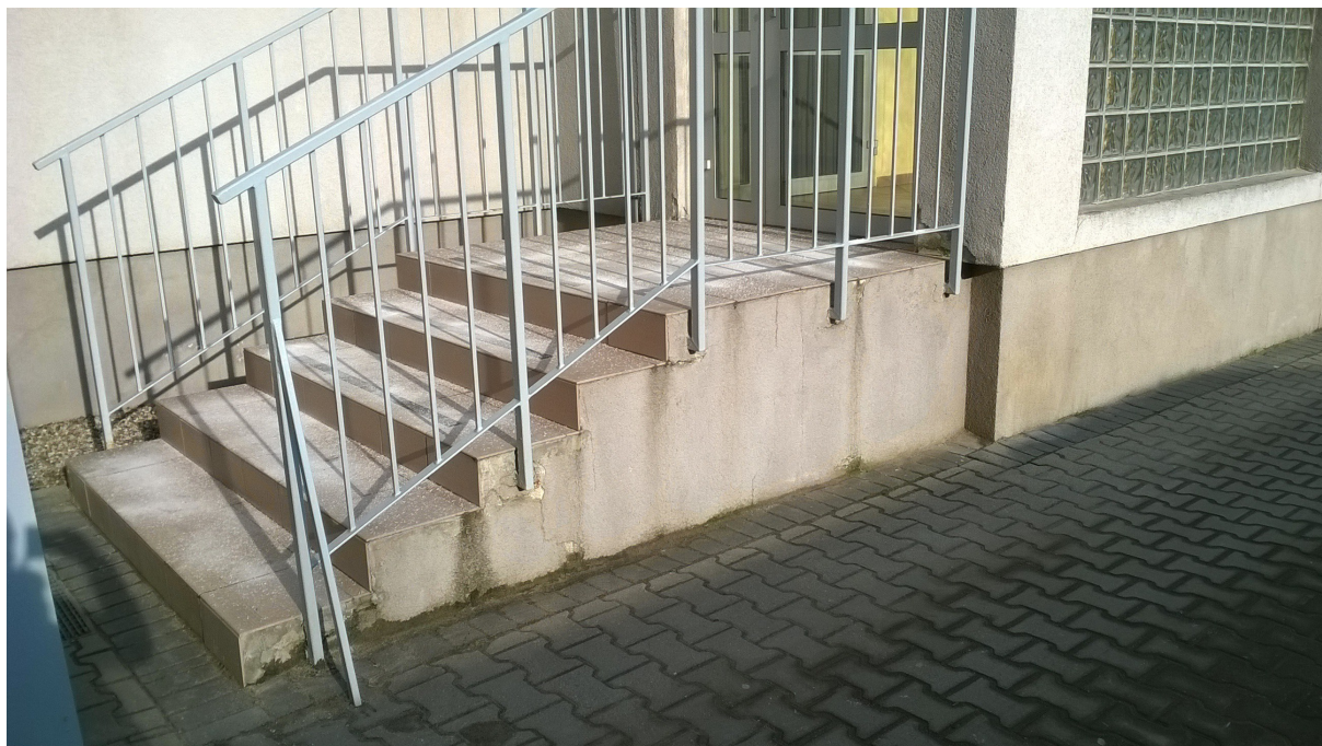
Fot. 7 Bok schodów przy klatce B
