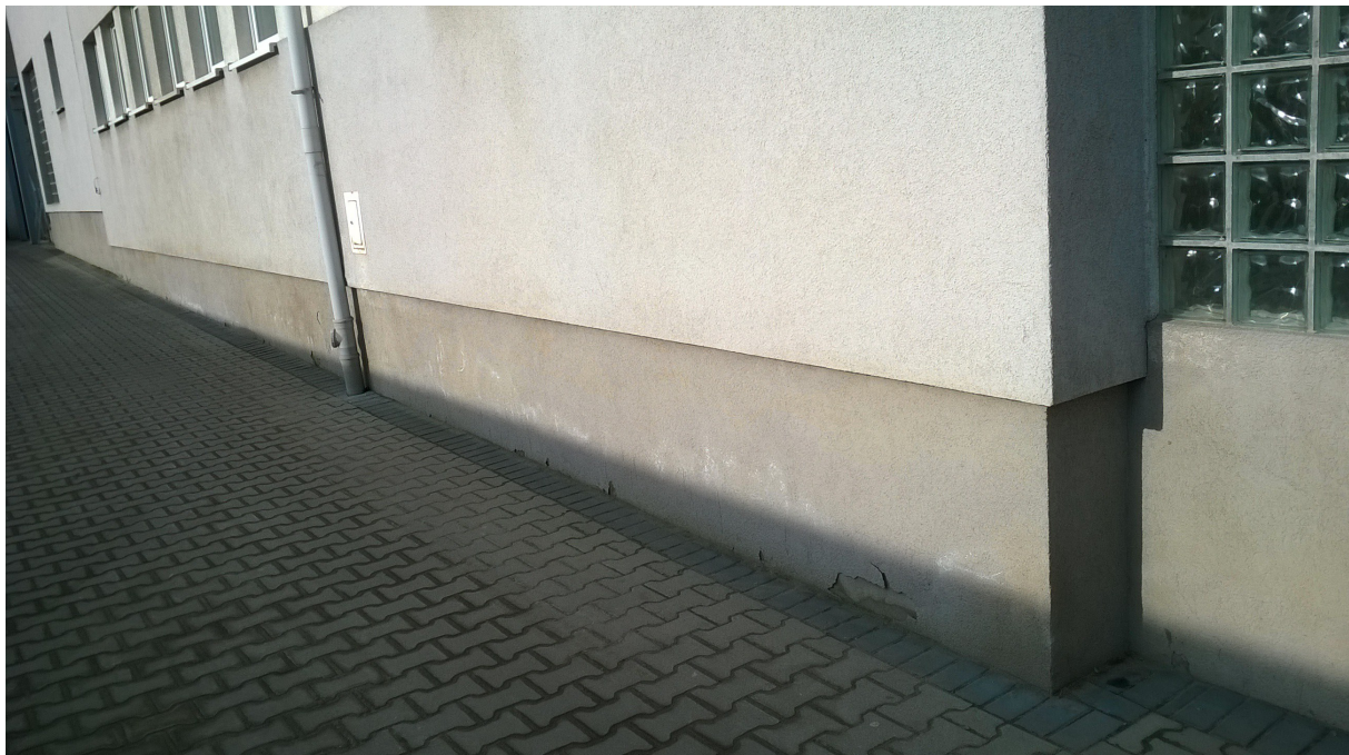
Fot. 6 Cokół między klatką E i B
