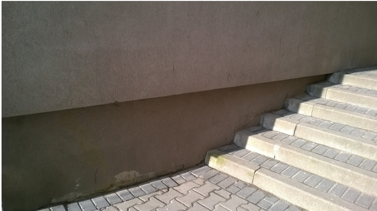
Fot. 1 Cokół przy zjeździe
