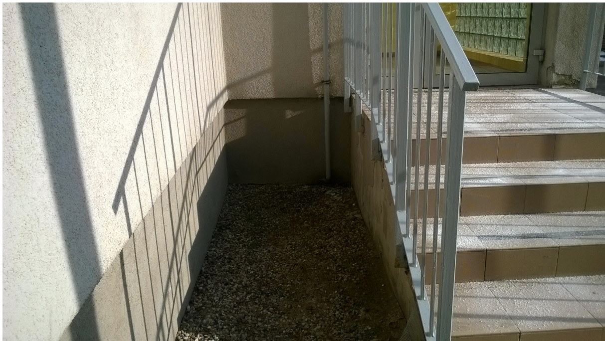
Fot. 9 Cokół między klatką A i B
