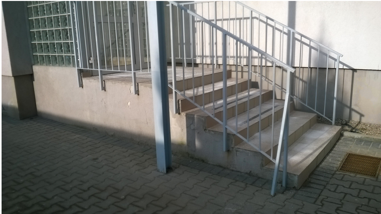
Fot. 5 Bok schodów przy klatce E
